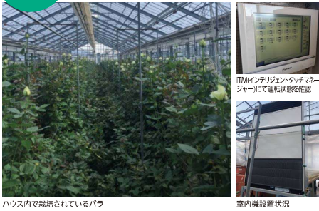
ハウス内で栽培されているバラ 室内機設置状況
