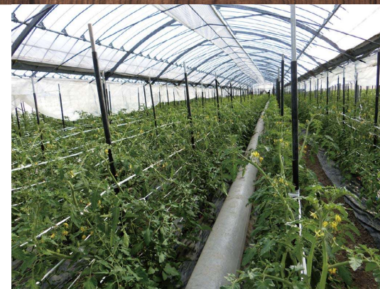
ハウス内の様子。室内機から伸びるビニールダクト。
