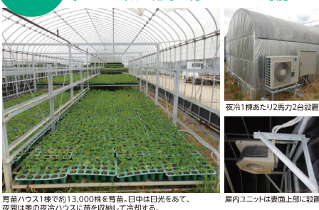
育苗ハウス1棟で約13,000株を育苗。日中は日光をあげ、夜間は奥の夜冷ハウスに苗を収納して冷却する。庫内ユニットは裏面上部に設置
