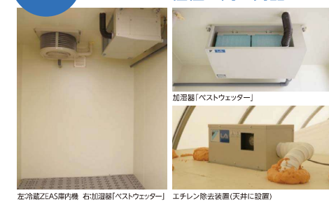
左冷蔵ZEAS庫内機 右加湿器(バストウェッター) エチレン除去装置(天井に設置)
