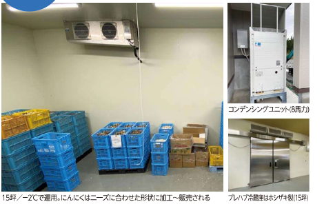
15坪、-2℃で運用。にんにくはケースに合わせた形状に加工→販売される。フレハロ冷蔵庫はホシザキ製(15坪)
